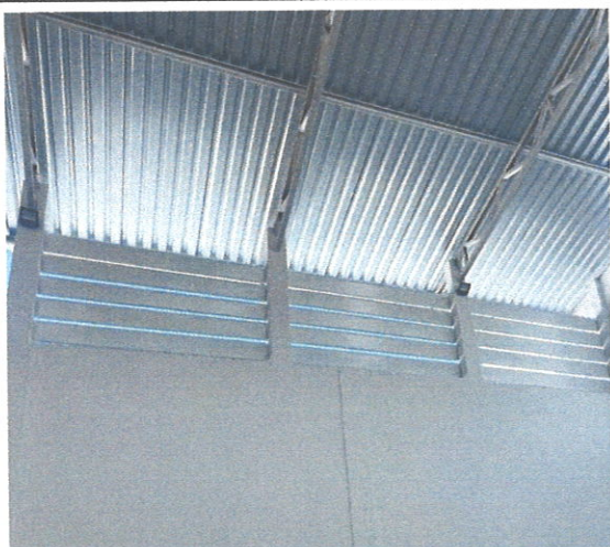
FOTO185: Instalação e pintura dos brises
