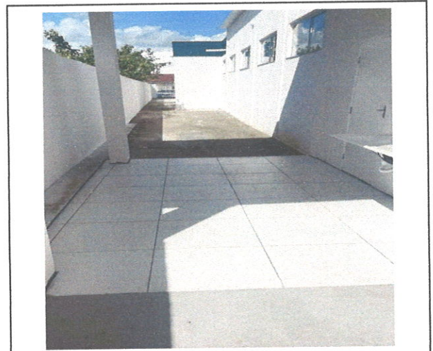
FOTO 180: Assentamento piso cerâmico 60x60
