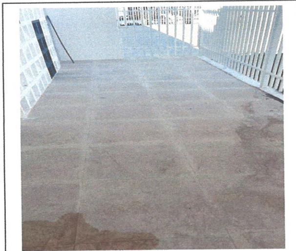
FOTO179: Assentamento piso cerâmico 60x60
