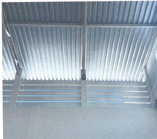
FOTO 184: Instalação e pintura dos brises
