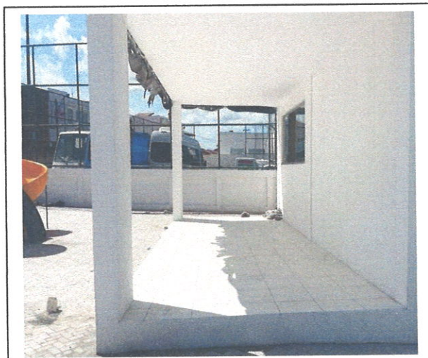
FOTO181: Assentamento piso cerâmico 60x60
